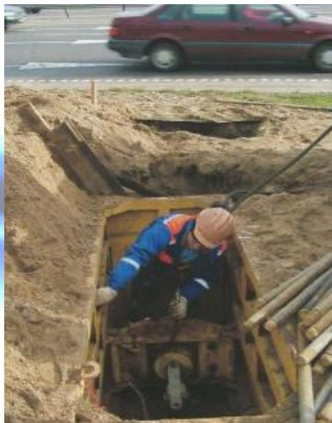
Применение в стесненных условиях при невозможности устройства котлована с откосами ограждающей конструкции опалубочного типа, препятствующей обрушению грунта
